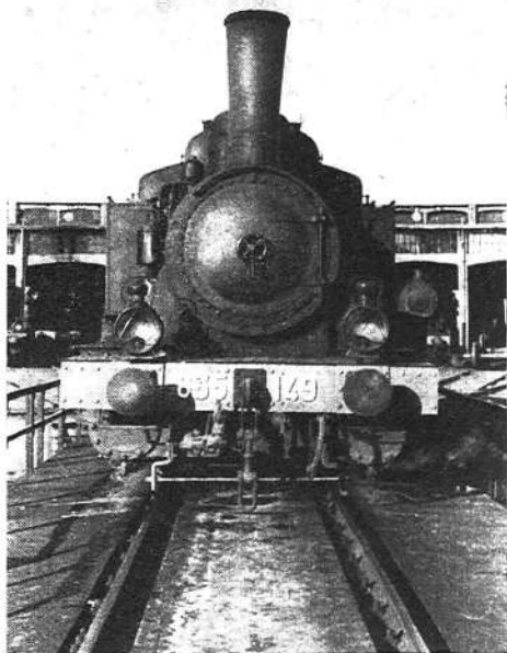
1903: La locomotiva GR. 680 R.M. (830 F.S. e derivato 835 F.S.) progettata dall'Ufficio studi di Torino per treni su linee incidentate; ebbe poi largo impiego per servizi di manovra. Potenza HP, 360. Vel. mass. Km. 55 orari.
