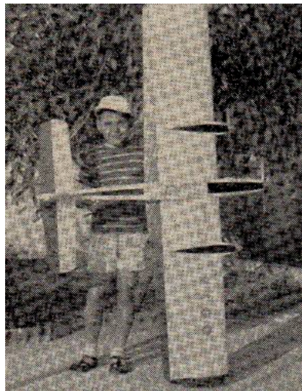
L'acrobatico trimotore di Giovanni Scuderi di Caccamo (PA), ap.alare 191cm, motore centrale G21/35, motore interno Webra 3,5cc, esterno G30, velocità 115 kmh. Foto Scuderi, Caccamo 1958.
